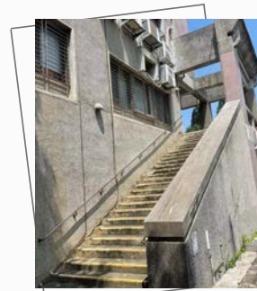
入口3 【鐘塔方向側樓梯】
